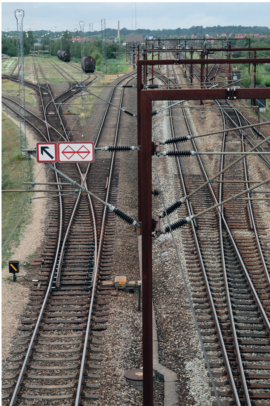
Som konsekvens af Storebæltsbroens åbning i 1998 anlagde Statsbanerne en ny linjeføring fra broen og ind til Nyborg Station. Det har krævet en grundig og pålidelig afvanding af det gamle vådområde.
